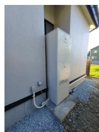
エコキュート設置
