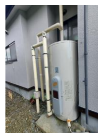
電気温水器撤去
