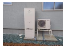
高効率給湯器設置
