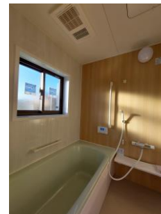
外窓交換、高断熱浴槽 手すり設置、段差解消
