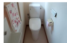
節水型トイレ、手すり設置
